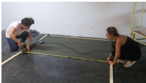
Figura 23 - Processo de Montagem
