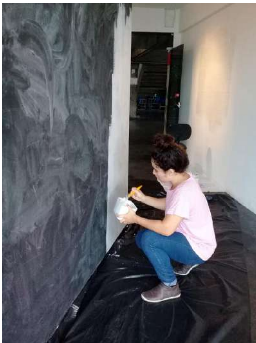
Figura 13 - Processo de Montagem (Pintura)
