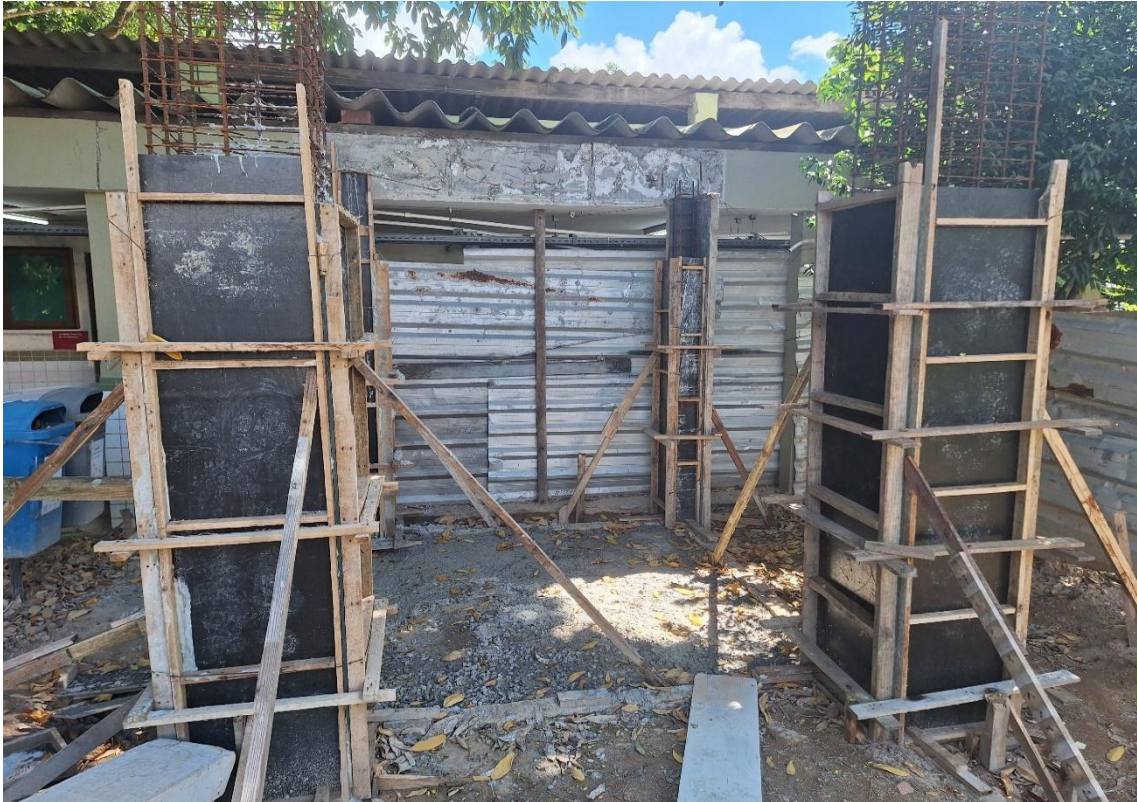
Montagem de forma de pilares retangulares, e concretagem de vigas e pilares
