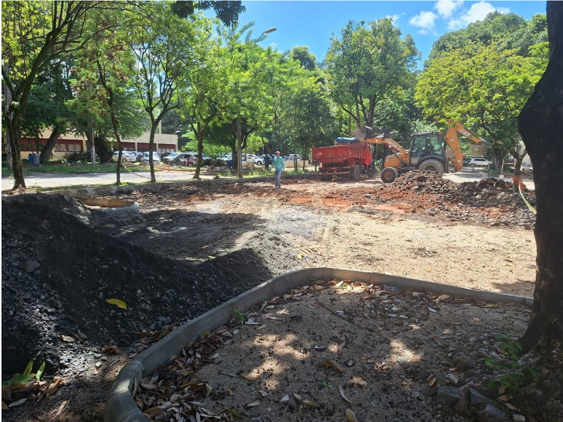
Retirada dos paralelos existente
