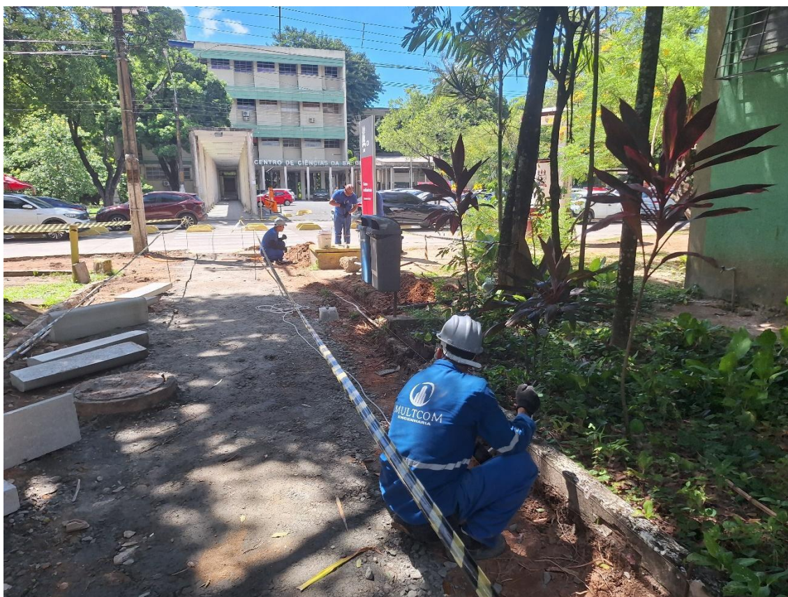
Nivelamento meio fio para execução da calçada externa
