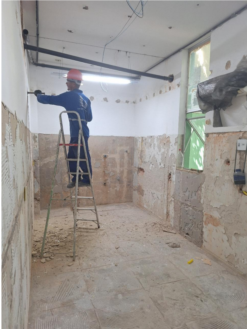
Demolição de revestimento cerâmico de forma manual
