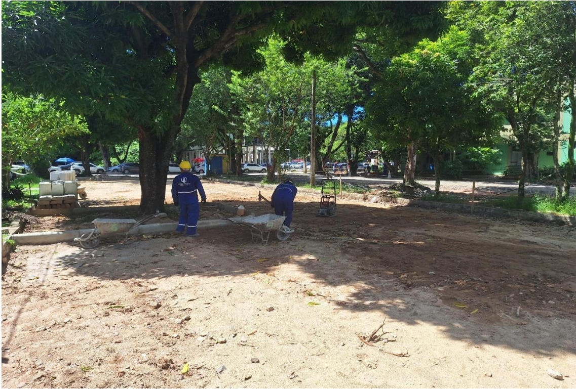
Assentamento de guia(meio-fio) em trecho curvo, confeccionada em concreto pré-fabricado
