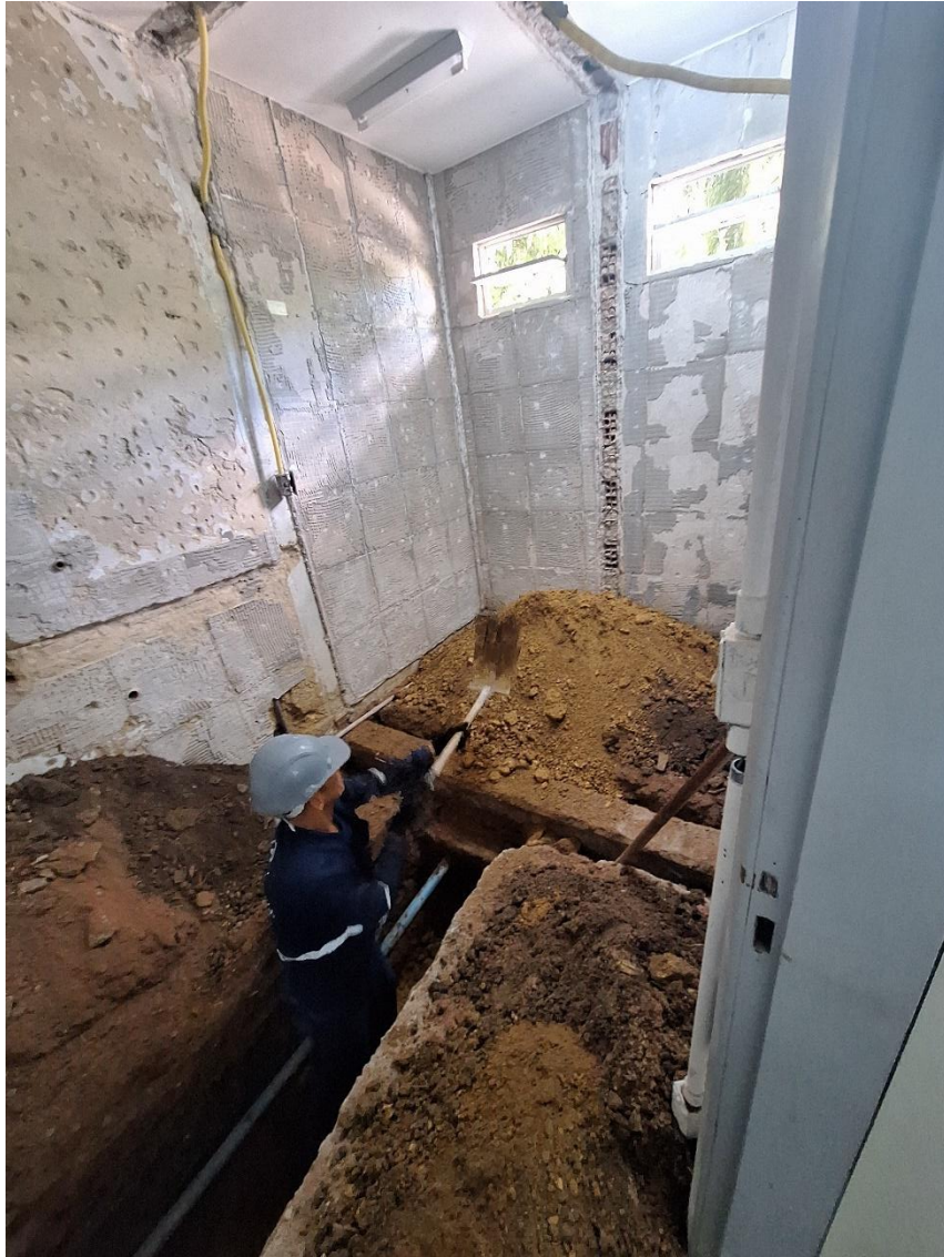
Escavação manual de vala
