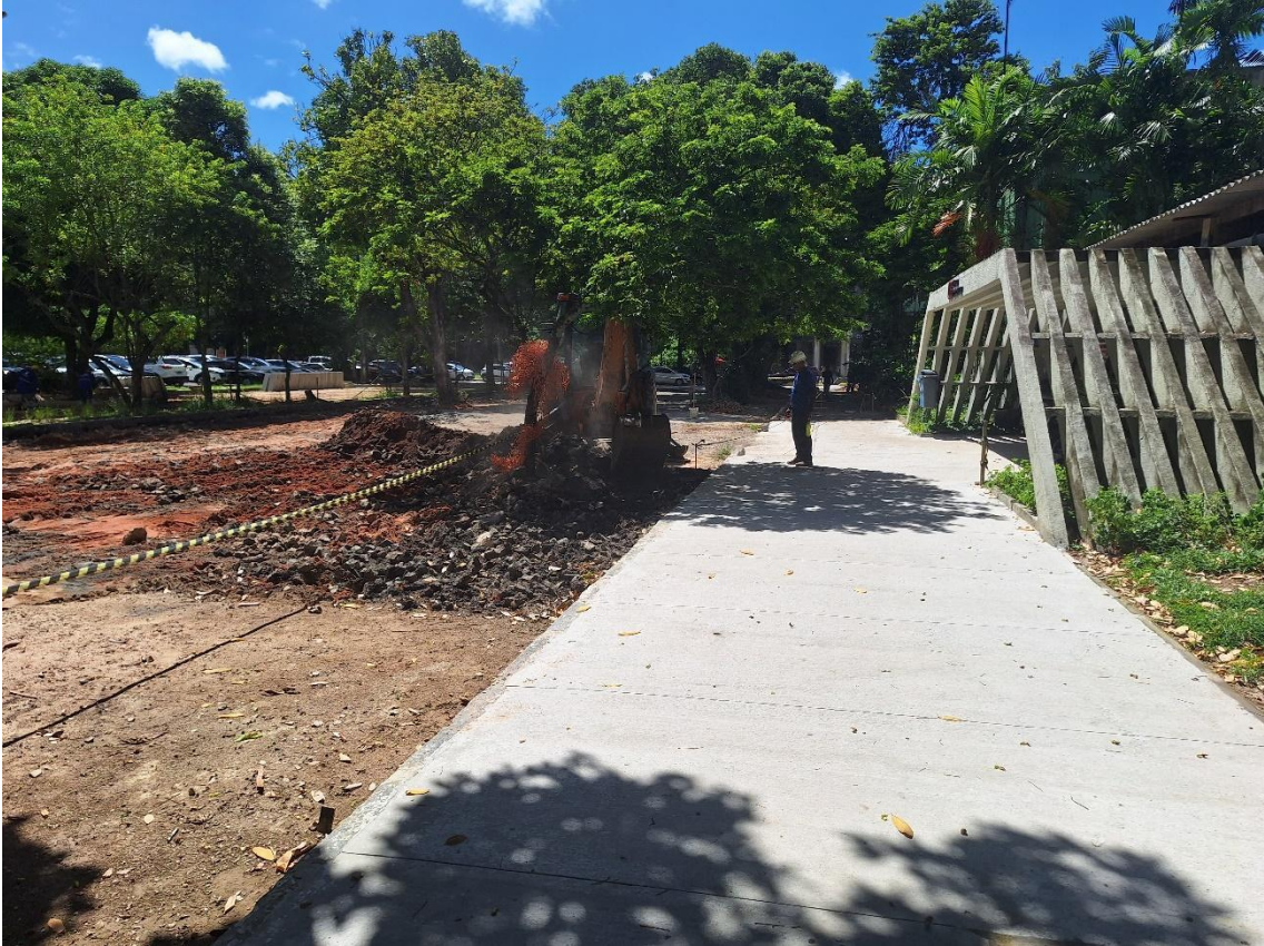
Demolição de piso em lajota de concreto e lastro de concreto
