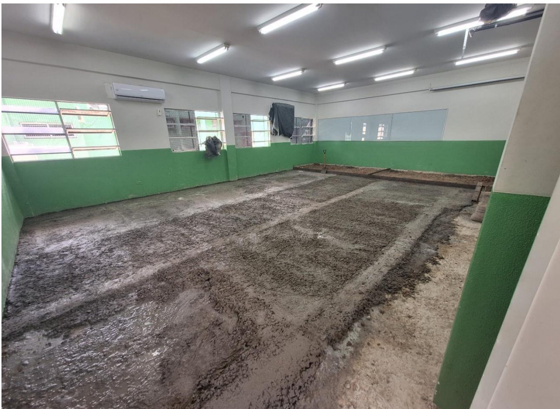
Regularização do piso com argamassa no traço 1:4 para receber o revestimento final em granilite
