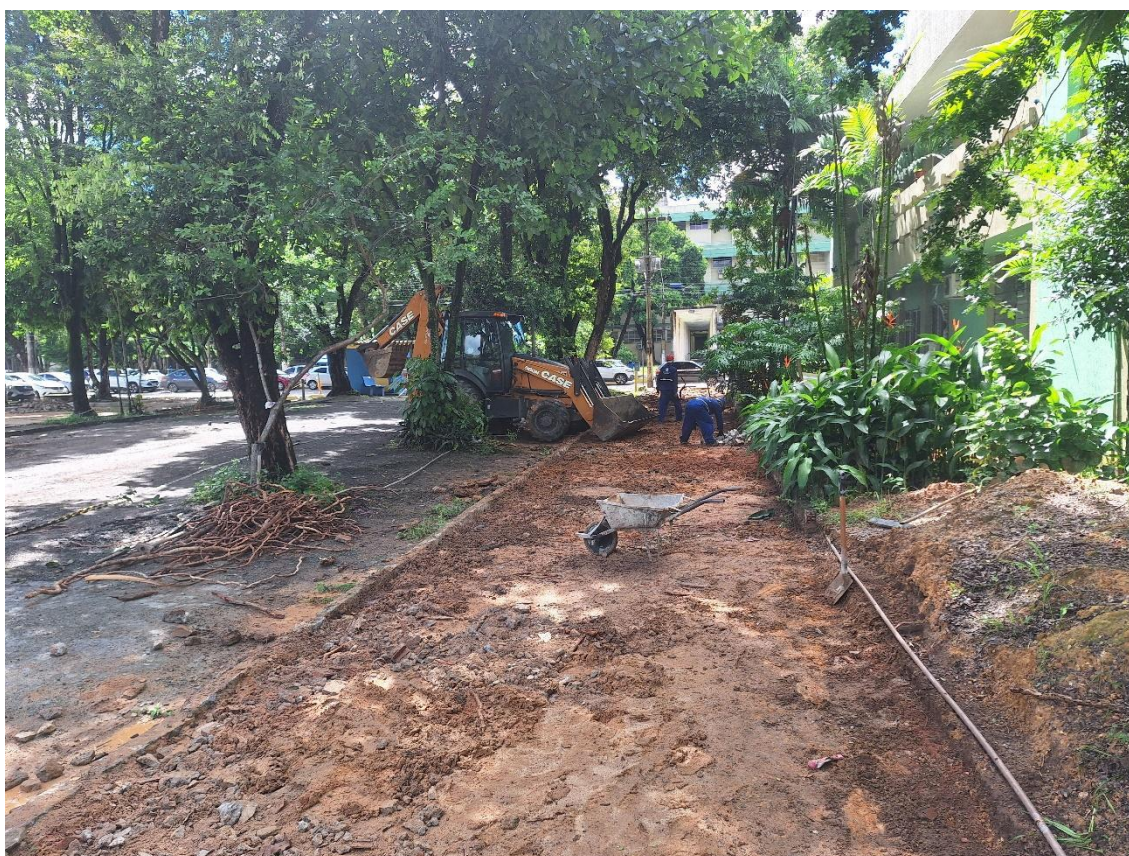
Nivelamento meio fio para execução da calçada externa
