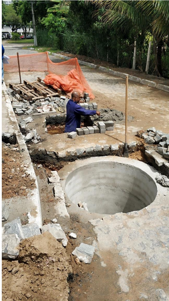
Foto 5: Construção de caixa para instalação da nova estação elevatória (próximo ao LITPEG)
