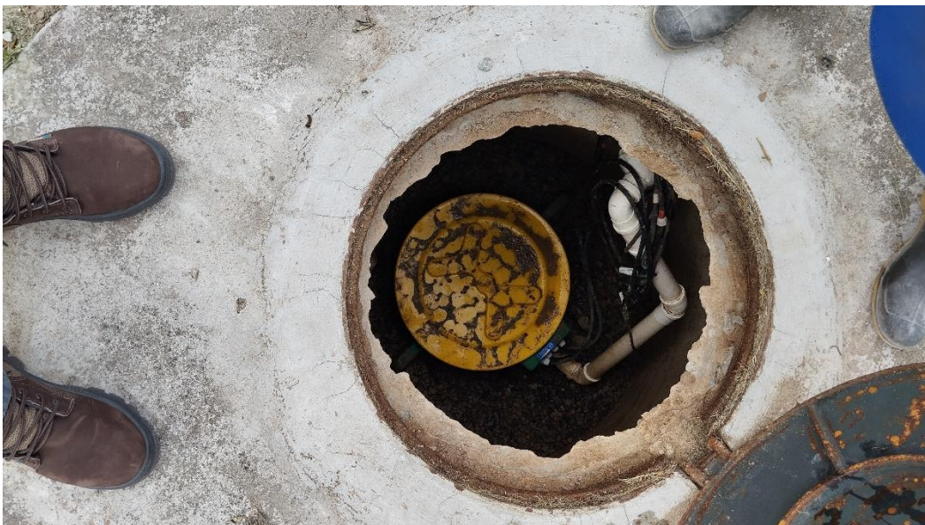
Foto 6: Instalação da nova estação elevatória
