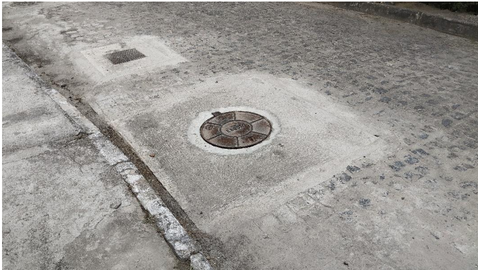
Foto 8: Conclusão das caixas e tubulações
