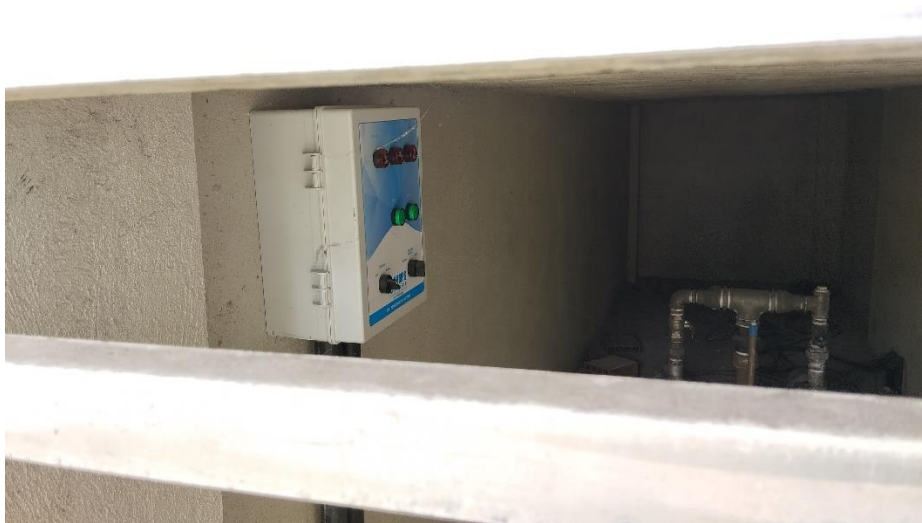
Foto 8: Conclusão dos quadros elétricos
