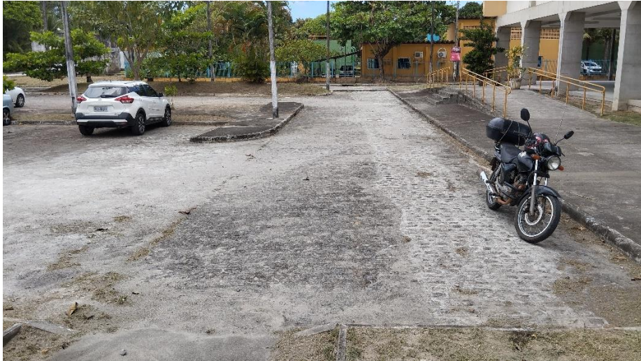
Foto 7: Recomposição do paralelepípedo
