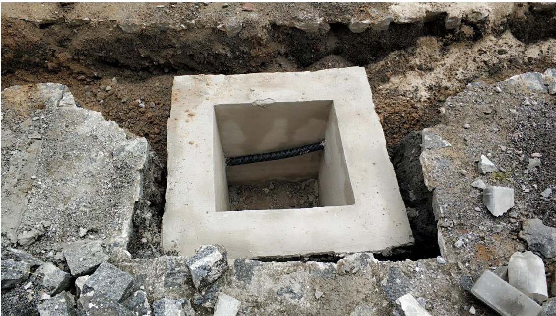
Foto 2: Construção de novas caixas
