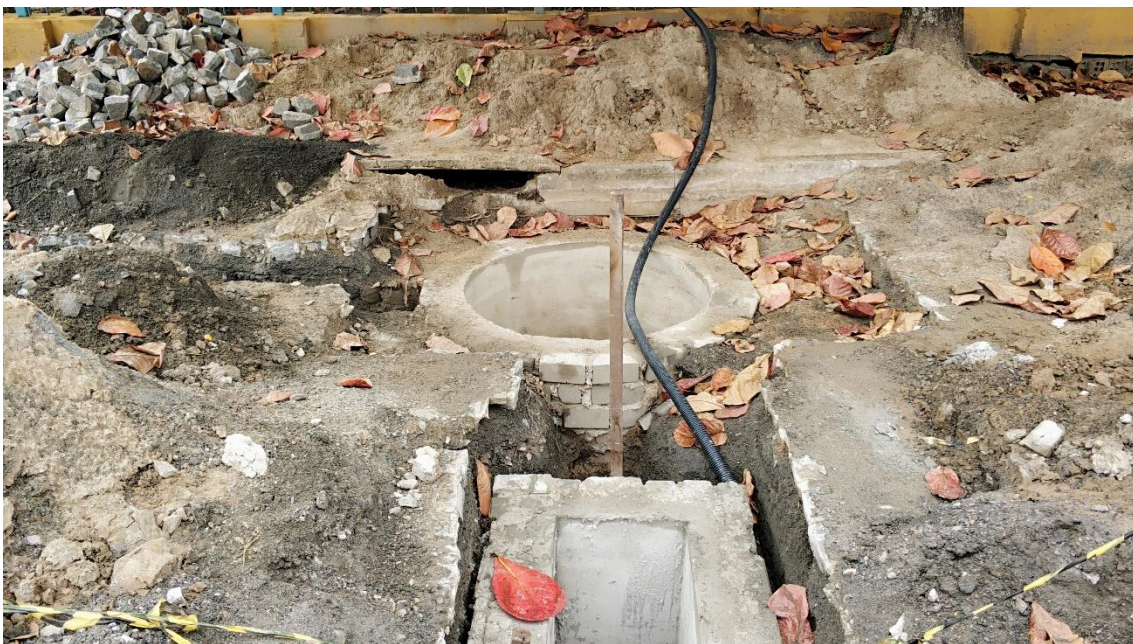
Foto 4: Escavação para instalação das tubulações e construção da caixa para instalação das novas estações elevatórias
