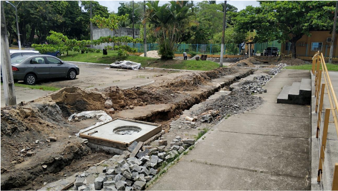
Foto 1: Escavação para passagem de tubulação e construção de novas caixas
