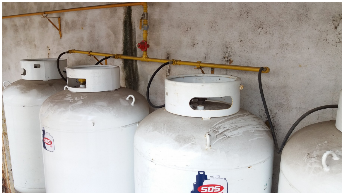
Figura 2: Coletor e Cilindros de GLP
